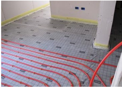
Figura 100: Messa in opera dei pavimenti radianti nelle abitazioni del Borgo del Benessere – Fonte: Comune di Riccia, Riccia. Il borgo del benessere, presentazione powerpoint per gentile concessione del Comune di Riccia.
