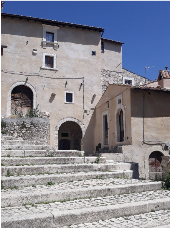
Figure 56, 57: Alcuni edifici recuperati a Santo Stefano di Sessanio.
