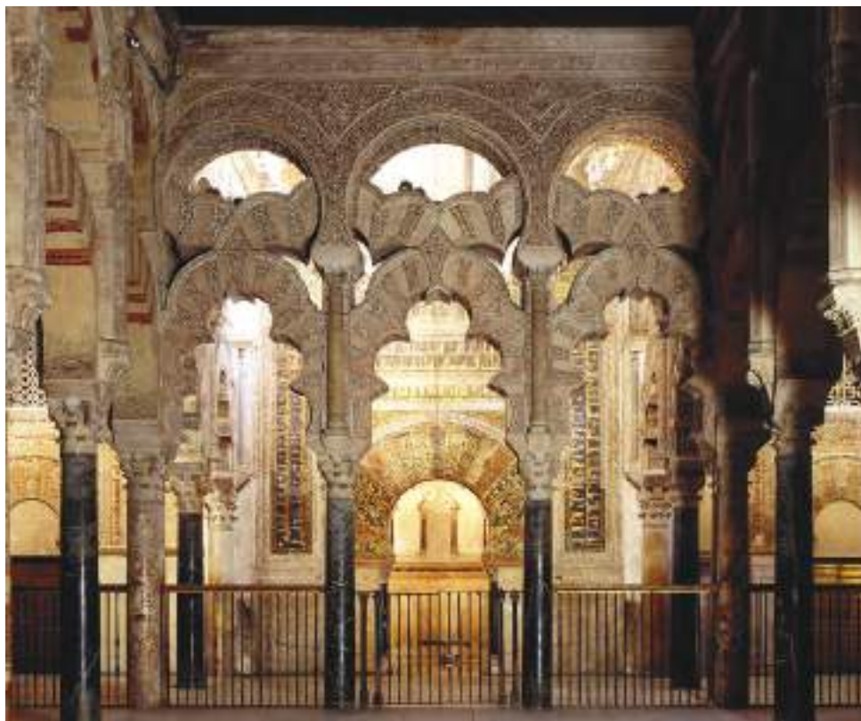
Cordova, Grande moschea. Gli archi della maqsura posti a sostegno delle imponenti cupole della zona sacra (X secolo)
